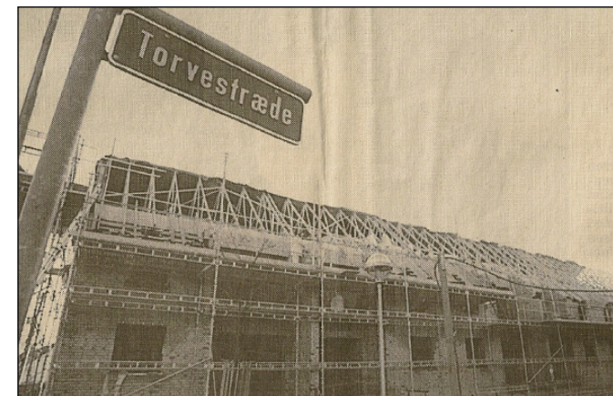
Her lå engang en maskinfabrik og et varmeværk. Nu efter fem år er midtbyrenoveringen ved at være færdig. Ældreboligerne er klar til indflytning i september. Foto: Claus Søndberg
