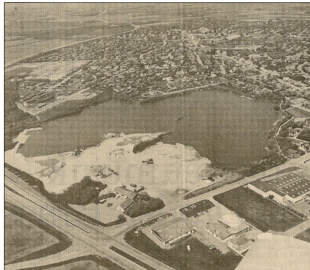
Formentlig flere hundrede kubikmeter tjære- og beholdigt materiale er gravet ned i den tidligere grusgrav i Aabybro
