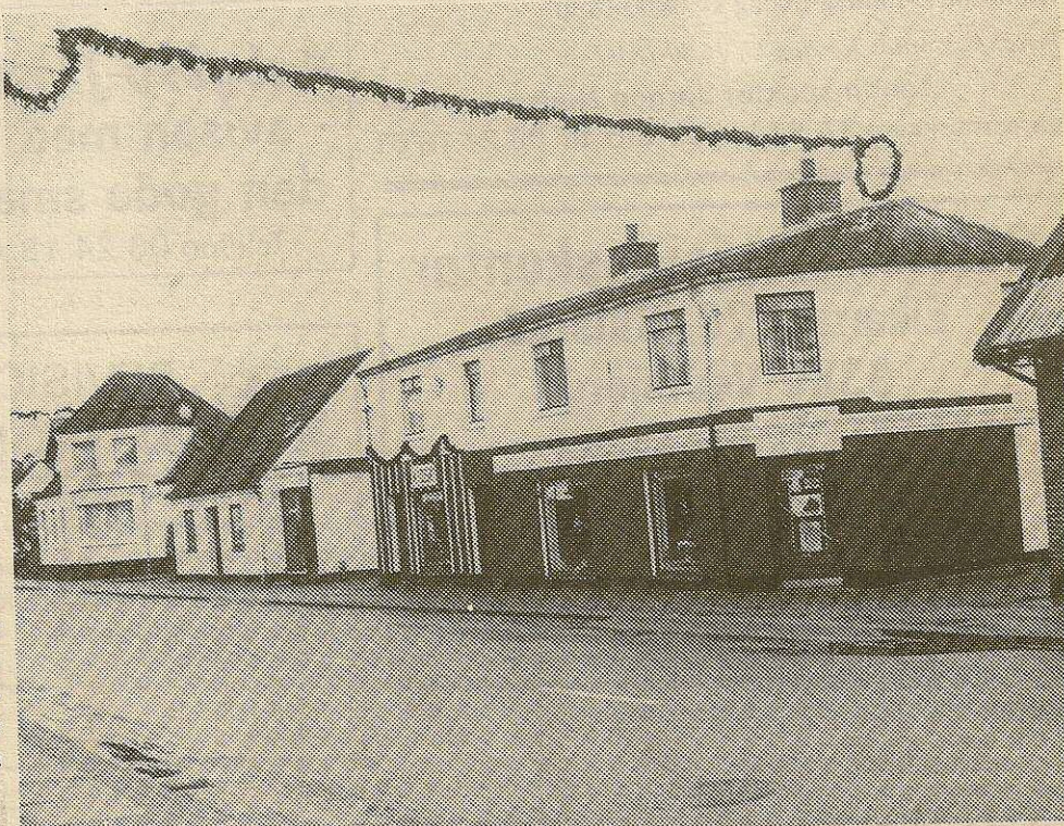
Det er bl. a. disse bygninger på Kattedamsvej, der skal nedrives for at give plads til den byfornyelse, der findes i SFs plan
